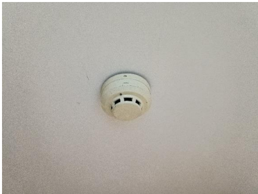
เครื่องตรวจจับควัน (Smoke Detector)
