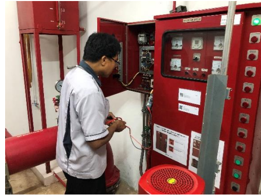
เจ้าหน้าที่ตรวจสอบอุปกรณ์ป้องกันอัคคีภัย ภาพที่ 2.2-11(ต่อ) ระบบป้องกันและแจ้งเตือนอัคคีภัย
